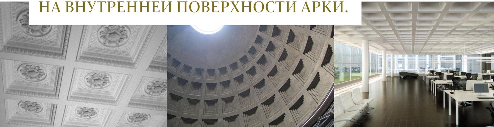
Кессоны могут иметь как чисто эстетическое значение, так и совмещать конструктивную и декоративную функции, а также использоваться для улучшения акустики помещения, создания различных визуальных эффектов (например, визуально увеличивать высоту потолка или свода), служить нишами для установки светильников.
